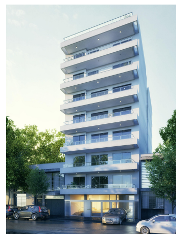
CALLE 40 N° 1136 LA PLATA EN EJECUCIÓN
