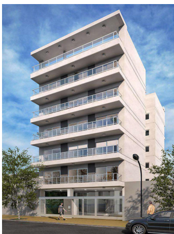
CALLE 14 N° 161 LA PLATA EN EJECUCIÓN
