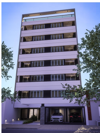
ATALIVA ROCA N° 169 JUNÍN TERMINADO (5M OBRA)
