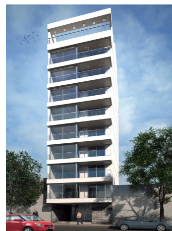
CALLE 54 N° 713 LA PLATA TERMINADO (5M OBRA)
